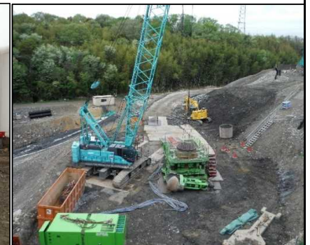
⑤ 底面・側面遮水工 全旋回再生コンクリート打設準備が完了しています。
