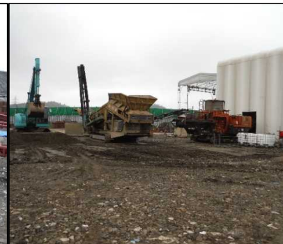
④ 選別処理工 E区画施工のため粗選別ヤードを移動しました。
