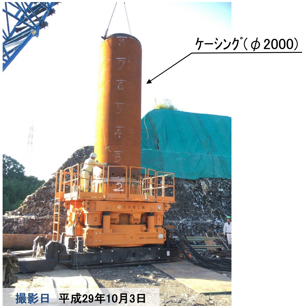
③ケーシング設置状況
