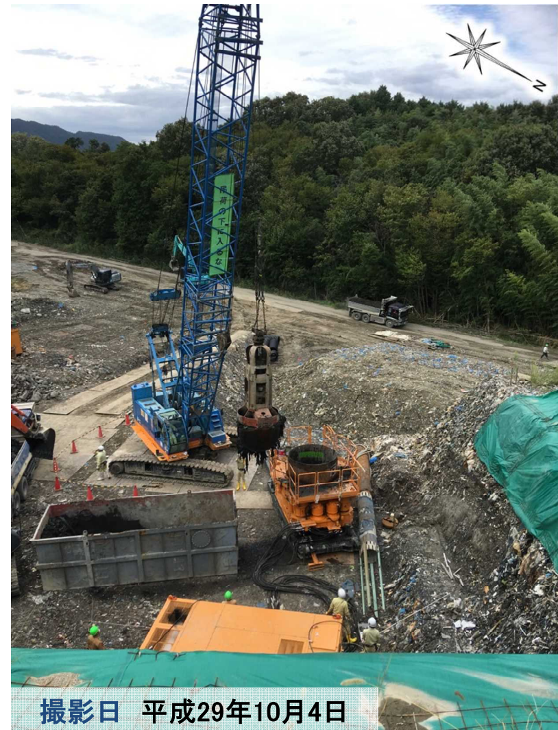
④掘削状況
