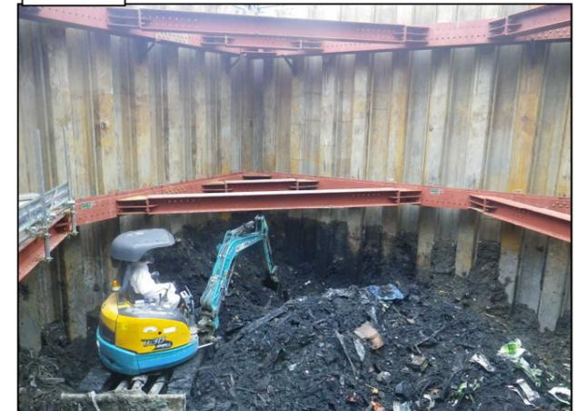
写真⑤ 4次掘削状況(有害物土)
