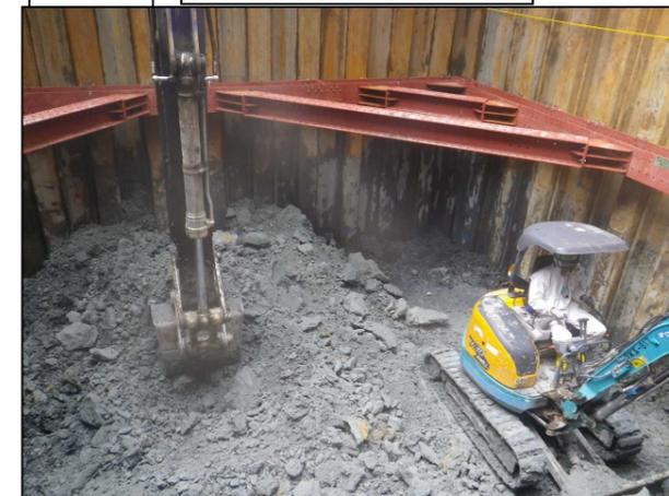
写真⑥ 有害物土掘削完了底面状況
