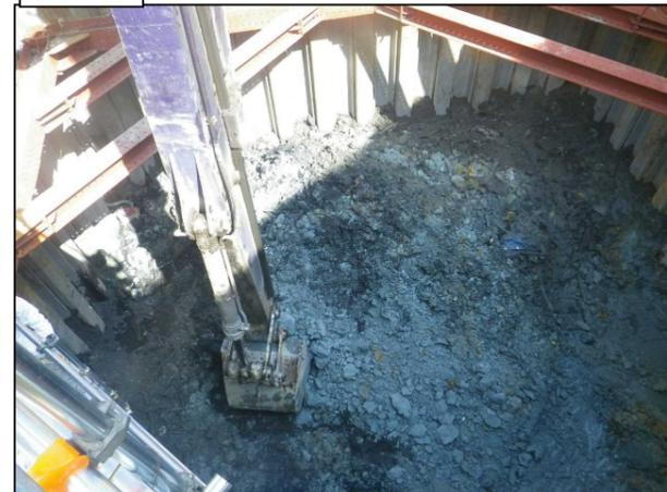
写真④ 3次掘削状況(有害物土)
