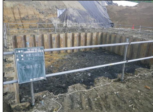
写真② 2次掘削状況(廃棄物土)
