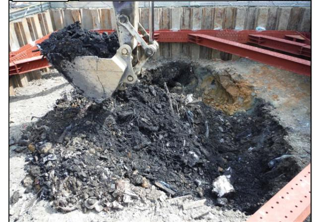
写真③ 3次掘削状況(廃棄物土)
