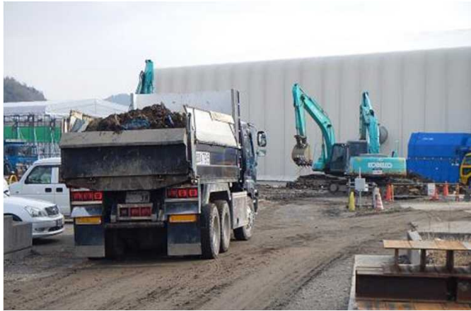
粗選別破碎ヤードへ廃棄物土運搬
