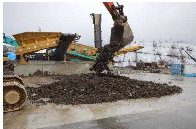
バックホウによる選別助剤攪拌
