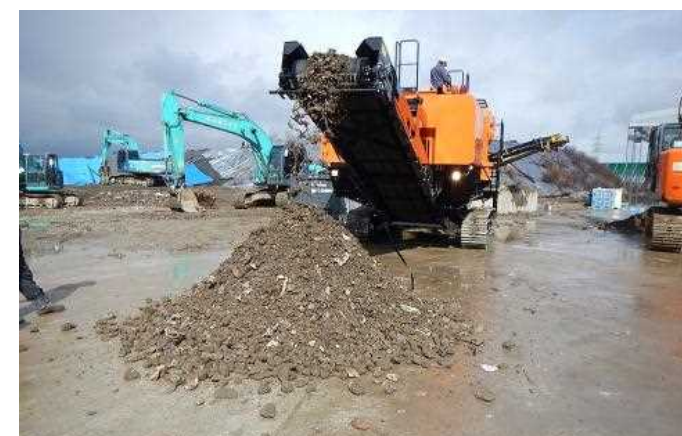
土質改良機による選別助剤攪拌等
