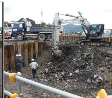
② 有害物掘削工 FG区画の掘削を行っています。
