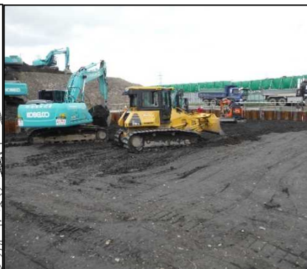
② 有害物掘削工 C区画の埋戻しを行っています。
