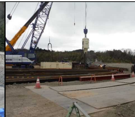
② 有害物掘削工 FG区画の鋼矢板打設、継杭を行って います。
