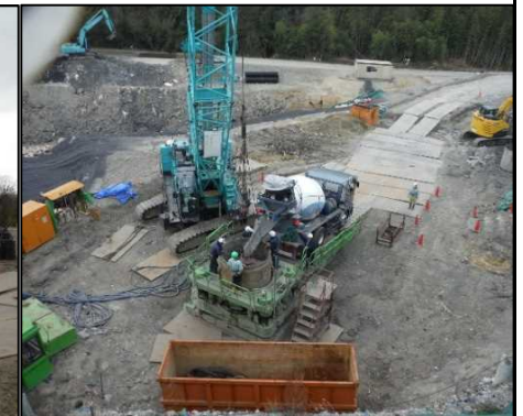
⑤ 底面・側面遮水工 生コンクリート打設を行っています。
