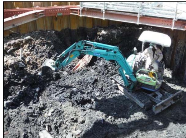
写真② 2次掘削状況(有害物土)
