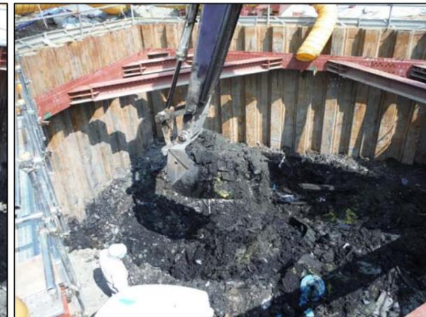
写真③ 3次掘削状況(有害物土)
