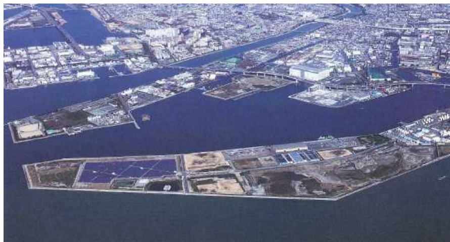
尼崎沖埋立処分場
