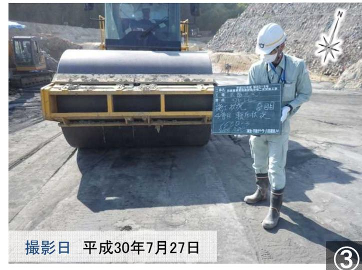
④ GPSとCCV(地盤の剛性値)評価により締固め状況を平面的に管理
