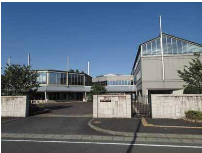
淡海環境プラザ外観
