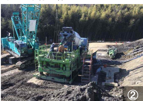
撮影日 平成31年(2019年)1月30日 ・生コン車によるコンクリート打設
