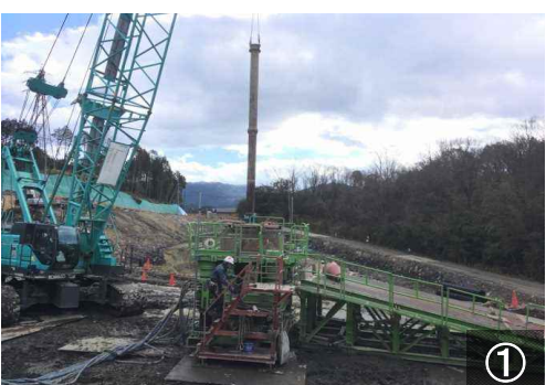
撮影日 平成31年(2019年)2月1日 ・生コン打設のためのトレミー管設置
