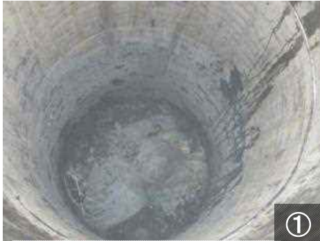
撮影日 平成31年(2019年)1月21日 ・廃棄物土の撤去完了 →地山部確認し、掘り止め
