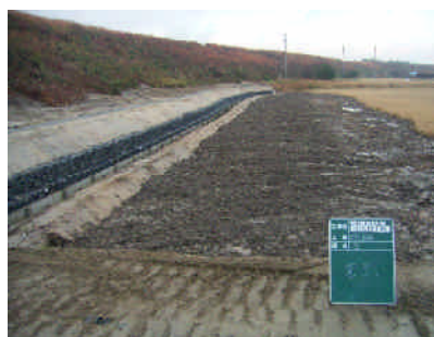
【堤防の漏水対策(祖父川)】
