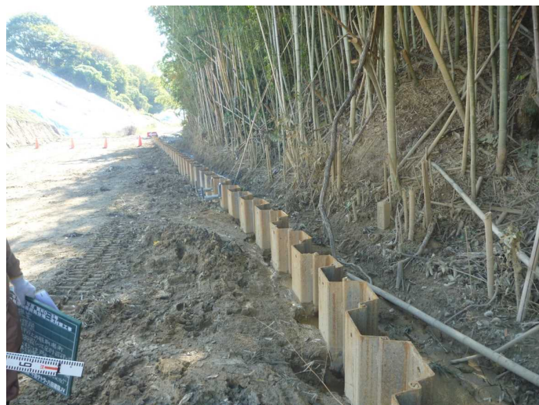
打設が完了した矢板
