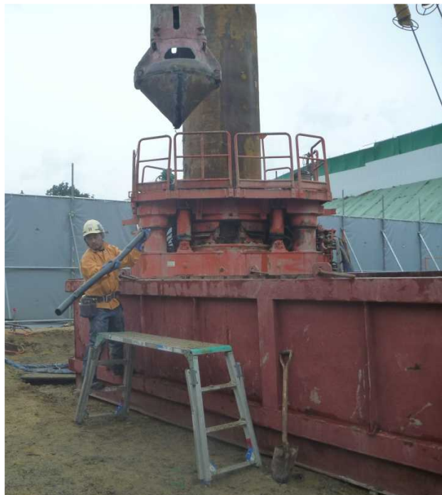
全旋回掘削機
