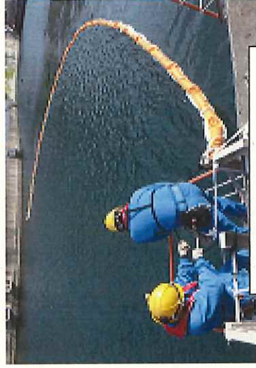
シルトフェンス設置
