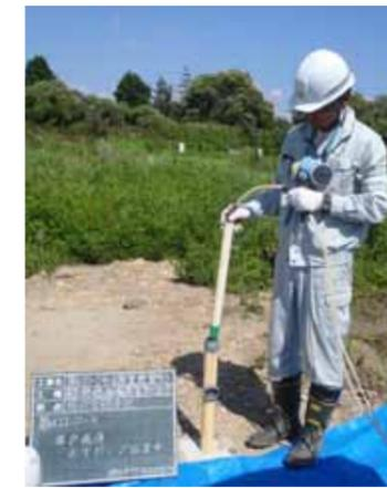
写真-2 水中ポンプの挿入状況
