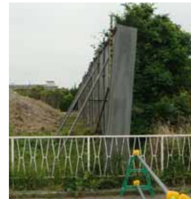
写真-4.4.1 仮囲いの例
