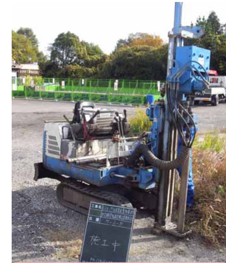
写真-2 掘削マシンの掘削状況
