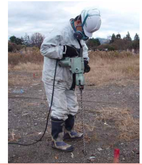
写真-3 ハンマードリルの掘削状況
