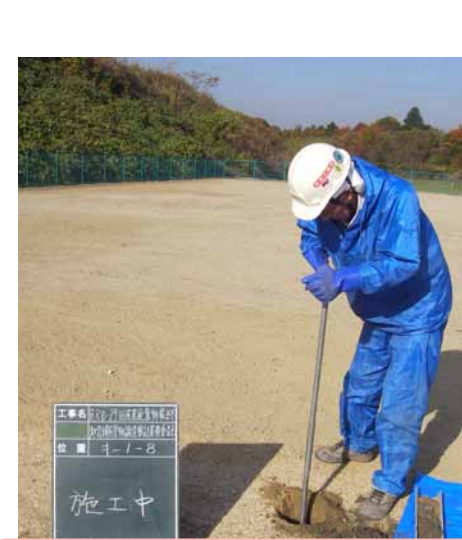
写真-1 ハンドオーガーの掘削状況
