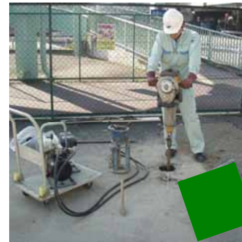
写真 1 ハンディ掘削マシンの掘削状況
