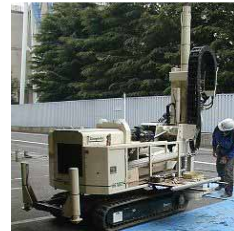
写真 2 掘削マシンの掘削状況
