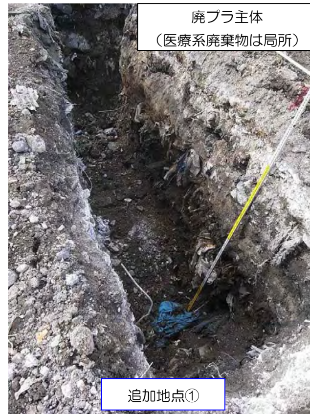
写真-1.1.1 各試掘箇所の掘削状況
