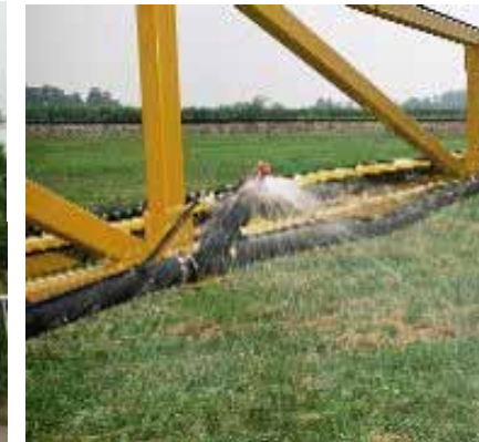
写真 2.6-2 スプレー散水の例
