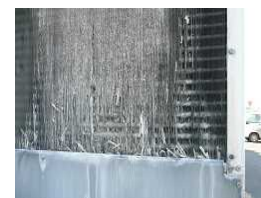
室外機の腐食
