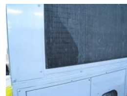
室外機の油にじみ
