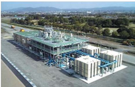
超高度処理実証施設（湖南中部浄化センター）2,475m 3 /日
