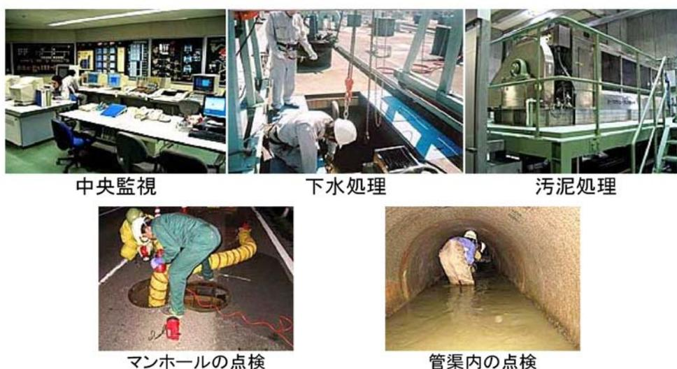
図 3-2-44. 下水道施設の管理状況
