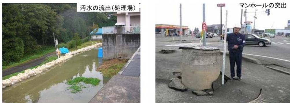
図 3-2-27. 新潟県中越地震における下水道施設の被害の状況
