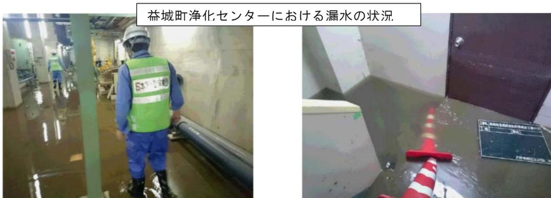
図 3-2-29. 熊本地震における下水道施設の被害の状況
