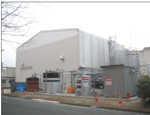
図-1 実証試験設備
