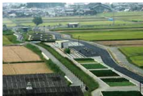
山寺川市街地排水浄化施設「伯母川バイオ・パーク」
