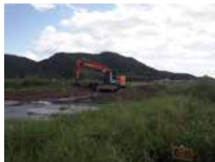
刈取除去した水草の堆肥化
