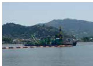
底質改善対策 (高濃度薄層浚渫)
