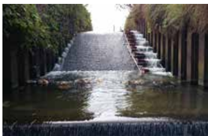
落差工に設置した魚道
