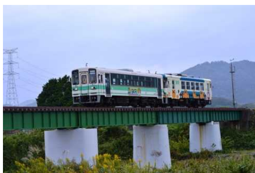
復旧した杣川橋梁（信楽高原鐵道）
