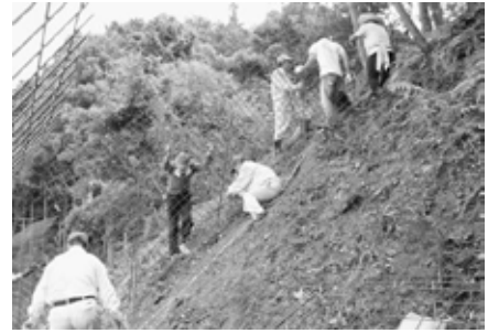
鳥羽上北町での獣害柵設置の様子
