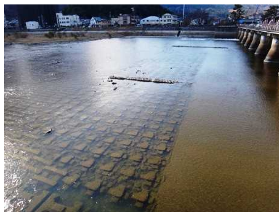
写真1 ch5が長期間とどまっていた水域周辺
