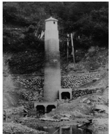
▲施工中の取水塔 [撮影：石井田勤二氏、 提供：高島市教育委員会]
