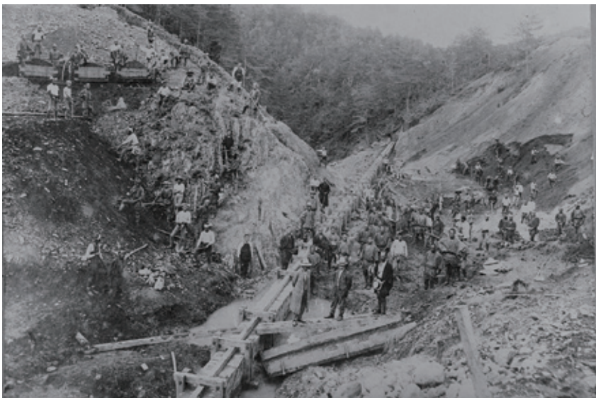
▲施工中の斜樋・底樋 [撮影：石井田勤二氏、提供：高島市教育委員会]
