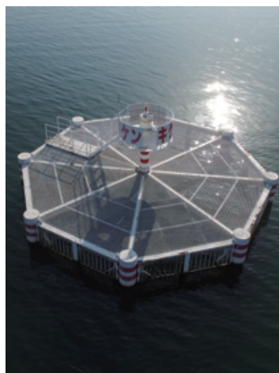
▲取水塔（高島市） [提供：鴨川流域土地改良区]
