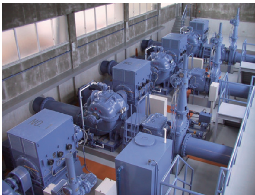
▲鴨川第1段揚水機場（高島市）[提供：鴨川流域土地改良区]
