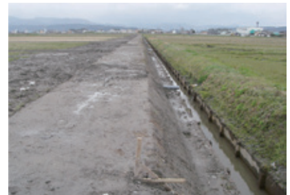
▲排水路側耕作道（高島市）
