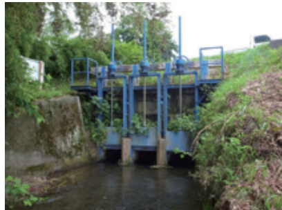
▲饗庭井取水水門（高島市） 【提供：安曇川沿岸土地改良区】
