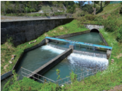
▲安曇川分水路（高島市） 【提供：安曇川沿岸土地改良区】
