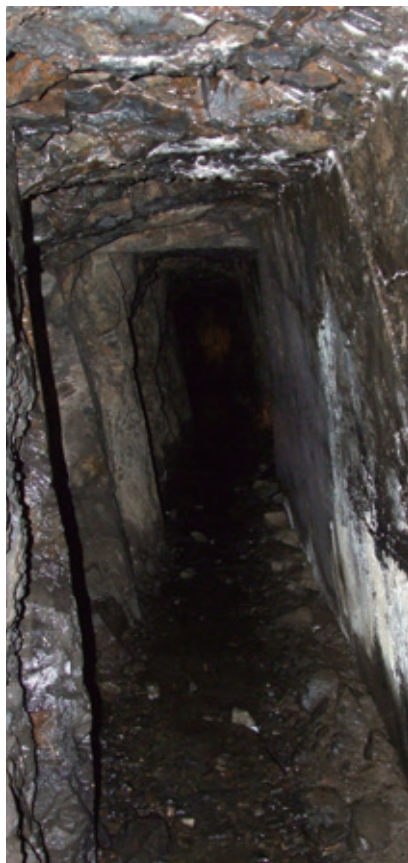
▲西野水道洞門内部（長浜市）[提供：滋賀県]
