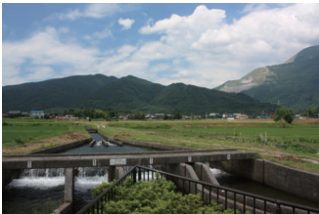
▲間田五川分水（米原市）【提供：米原市】
