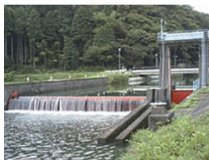
▲余呉川頭首工（長浜市） [提供：水土里ネット湖北]
