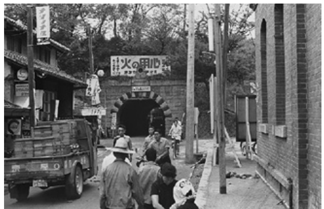
▲草津川トンネル付近 (草津市) [提供：滋賀県]
