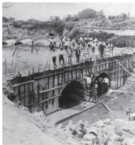
▲工事中の田川カルバート [提供：長浜城歴史博物館]
