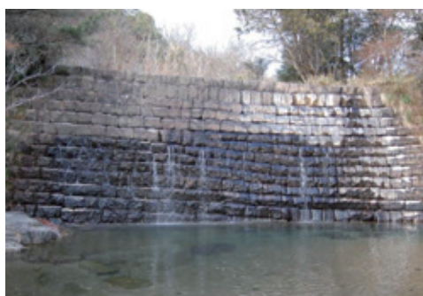
▲オランダ堰堤（大津市）[提供：滋賀県]
