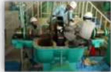
機能保全計画に基づく ポンプのオーバーホール
