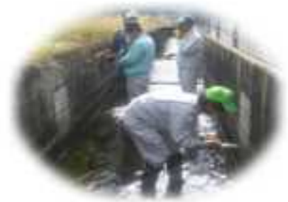
施設の機能診断
