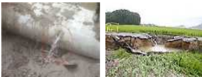
送水管の破裂による道路の陥没
