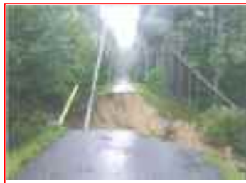
県道麻生古屋梅ノ木線 H25.9 台風 18 号による道路欠損
