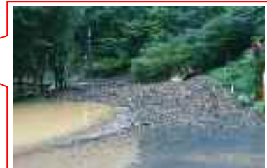
国道 421 号 H25.9 台風 18 号による土砂流出
