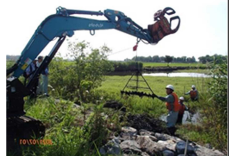
建設機械による試験施工
