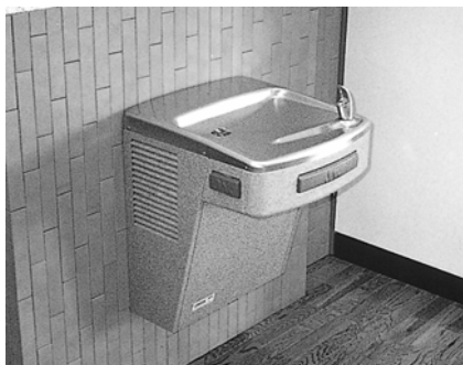
車いす使用者に配慮した水飲み器設置例
