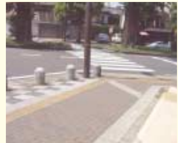
点字ブロックと色分けした段差のない歩道
