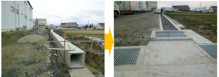
図 3-2-7. 守山市雨水渠の整備（施工中、完了）
