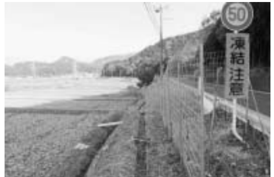
農地周辺に設置された侵入防止柵
