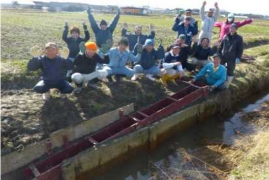
合成木材FFUの端材を活用して、「一筆魚道」を製作・設置
