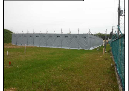
③浸透水井戸仮囲い完了
