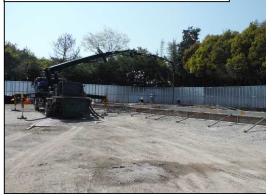
②浸透水处理施設生コン打設状況
