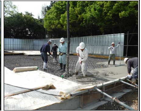
④浸透水処理施設設置工 水処理施設の基礎部分のコンクリートを打設しています。
