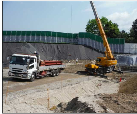
②有害物掘削除去工 A-1区画に圧入した矢板を支える支保工を搬入しています
