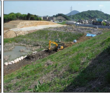
③仮設備工 揚水井戸を掘削するために搬入路を造成しています。
