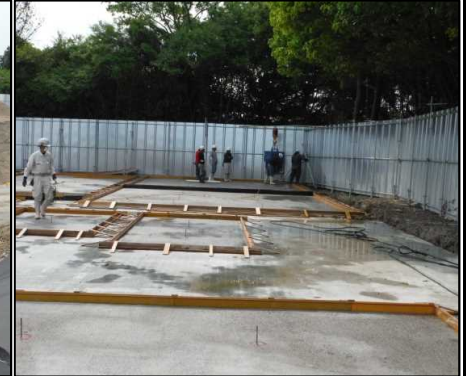
④浸透水処理施設設置工 水処理施設の基礎部分の調整コンクリートを打設しています。
