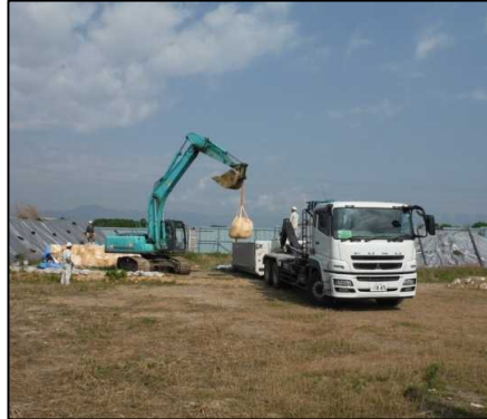
①仮置き物撤去工 仮置き物を搬出車両に積み込んでいます。
