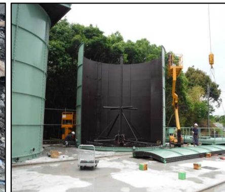
④浸透水处理施設設置工 原水貯槽の組立を行っています。
