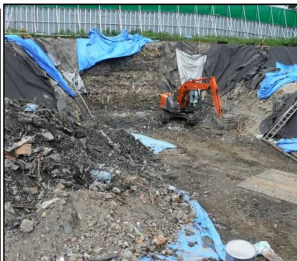
②有害物掘削除去工 B区画の有害物土掘削を行っています。
