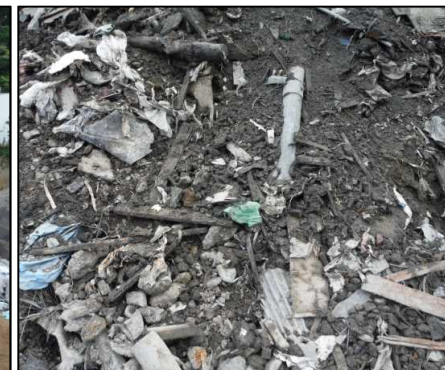
①有害物掘削除去工
