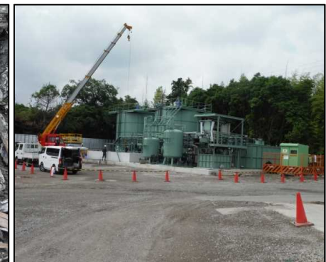
④浸透水处理施設設置工
