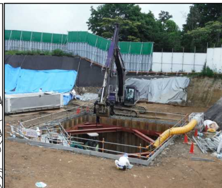
①有害物掘削除去工
