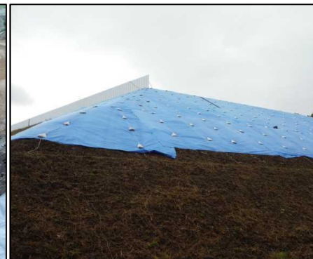
③仮設備工
