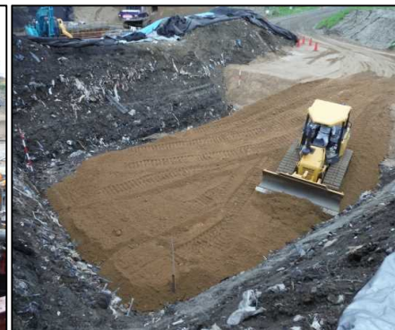
①有害物掘削除去工
